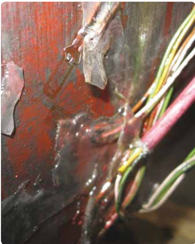
Obr. 2 Poškodená vrchná vrstva krytia tenzometrických snímačov prevádzkovaných v oleji pri teplote do 80 °C. Základná vrstva krytia však stále poskytuje dostatočnú izoláciu voči okoliu a meracie reťazce sú stále funkčné.
