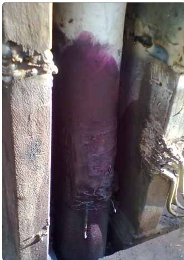
Obr. 4 Zničená kabeláž inštalácie tenzometrických snímačov z dôvodu nedostatočného krytia inštalácie
